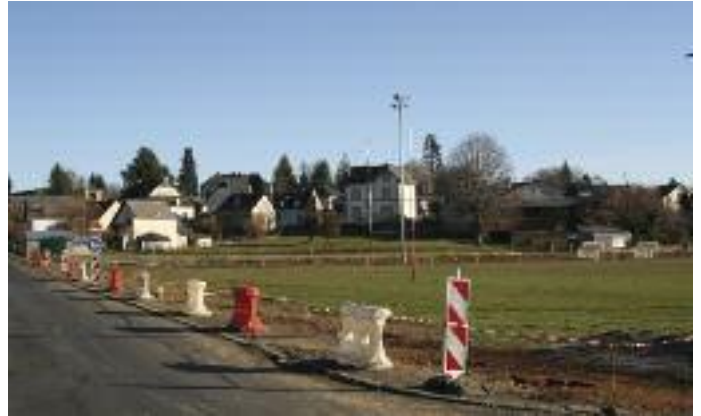
Installation de la clôture au Stade Calary
