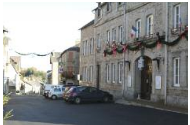
Accès handicapé à la Mairie et réfection de la place
