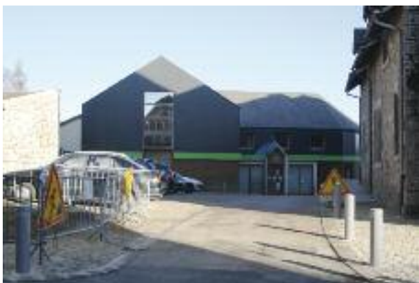
Fin des travaux du PAB autour de l'église
